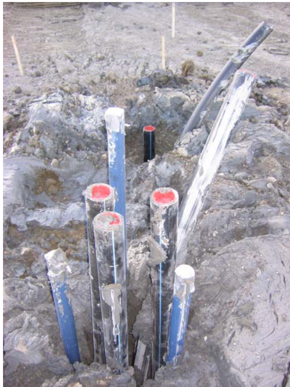
Figur 7. Pelare A8 försedd med mätrör; 1 st plastslang för geofoner, 3 st ytliga plaströr för exciteringskälla samt 3 st stålrör för ultrasonic.
