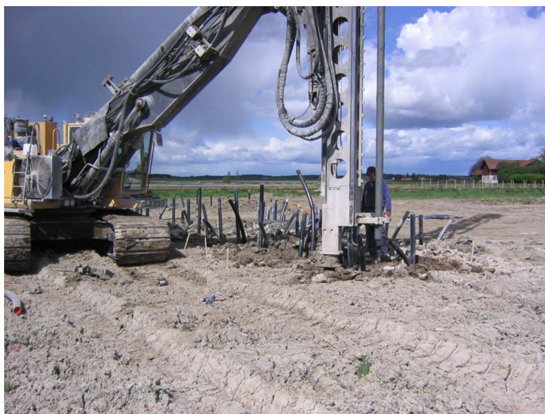
Figur 6. Installation av pelare med plastslangar och –rör för geofoner och exciteringskälla.
